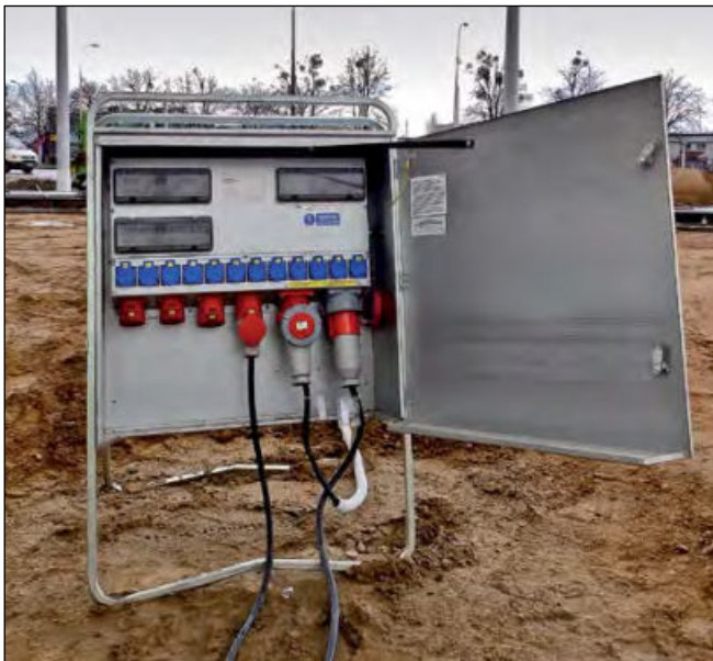
Zestaw ACS wyposażony w drzwi, których nie zamyka się podczas normalnego użytkowania.
